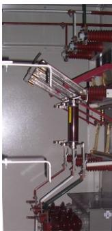
El seccionador de potencia FELMEC puede instalarse de forma lateral; en este caso el mando es directamente sobre su eje, sin necesidad de mecanismo ni varillaje de transmisión, lo cual simplifica su instalación y maniobra. En la imagen se observa un seccionador de potencia tipo **SpaI-B**, instalado lateralmente en una celda que contiene también un TRAFOMIX
