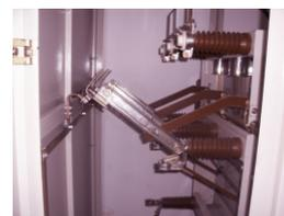
La vista parcial corresponde a una celda de salida equipada con un Seccionador de Potencia instalado **lateralmente** y con puesta a tierra automática en la posición "abierto". Esta ejecución permite reducir el ancho de la celda a 600 mm para 12 KV y a 850 mm para 24 KV.
